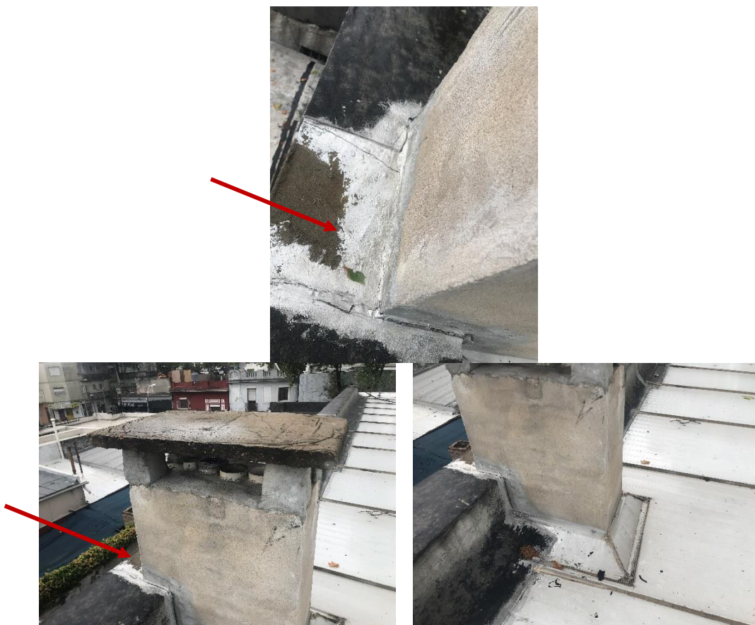
Sector techo contra muro medianero y encuentro con ducto. Sector sin terminaciones.
