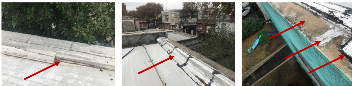
Sector techo contra muro medianero y encuentro con ducto. Sector sin terminaciones.
