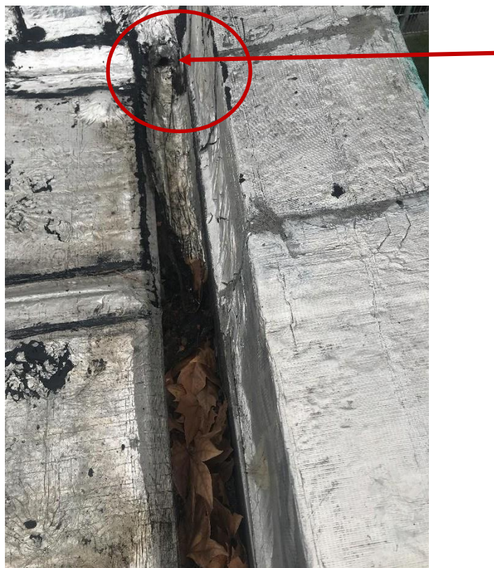
Desborde sobre fachada, prácticamente cerrado por la membrana.
